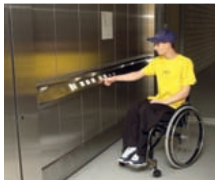
Ascenseur avec tableau de commande horizontal
