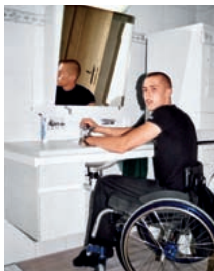
Lavabo avec évidement, siphon encastré et miroir inclinable
